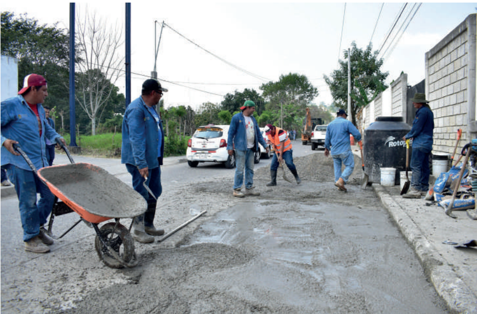
La Comisión del Agua del Estado de Veracruz (CAEV) trabaja en la reparación de un drenaje colapsado en Coatzacoalcos.
